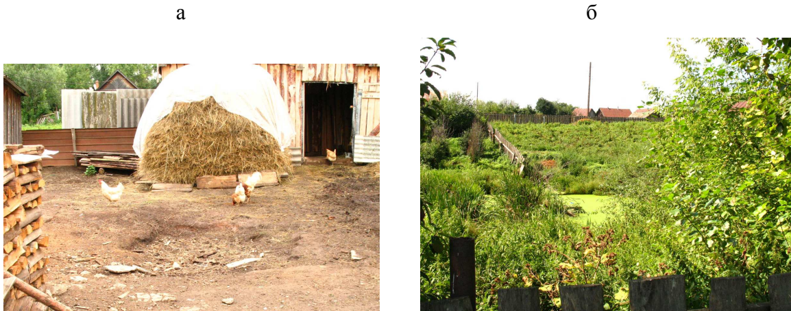
Рис. 1.6. Просадка земной поверхности на месте засыпанной воронки, образовавшейся весной 2002 г. в пос. Салауш по ул. К. Маркса, 11 (а) и оседание склонов старых карстовых воронок по ул. Советской (б) (фото А.С. Чумаченко).
