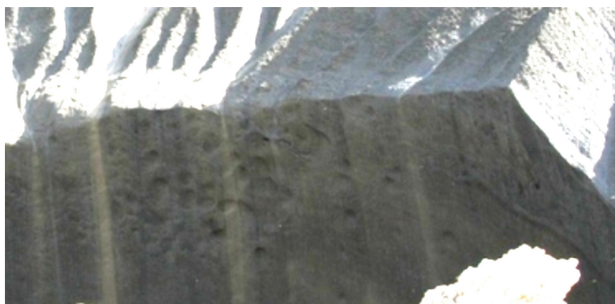
Рис. 4.64. Каверны на поверхности свода над газонасыщенной зоной (фрагмент рис. 4.63)
