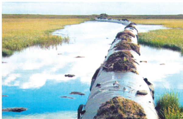
Рис. 5.22. Развитие термокарста на участке газопровода. Фото В.В. Лашина [Грива, 2006]
