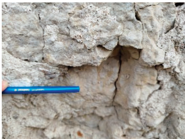
Рис. 2б. Микритовые слабо доломитизированные известняки с характерными следами илоедов типа Balanoglossites в облицовке стен церкви Спаса Нерукотворного
