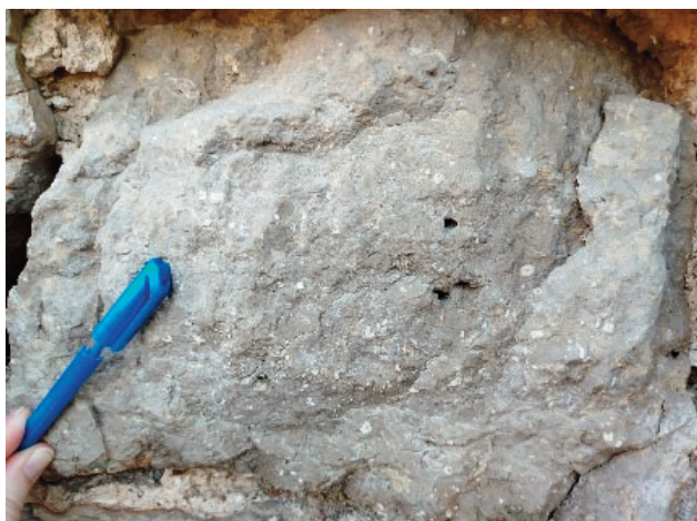
Рис. 3б. Сильно доломитизированные микритовые известняки с детритом криноидей и редкими ходами илоедов в облицовке Гремячей башни
