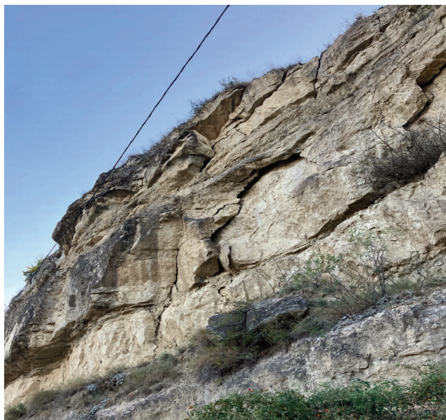
Рис. 1. Фото неустойчивого массива с вертикальными отрывными трещинами
