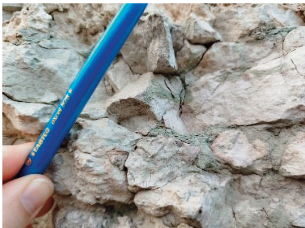
Рис. 4б. Микритовые сильно биотурбированные известняки с прослоями известковистых глин в облицовке Михайловской башни
