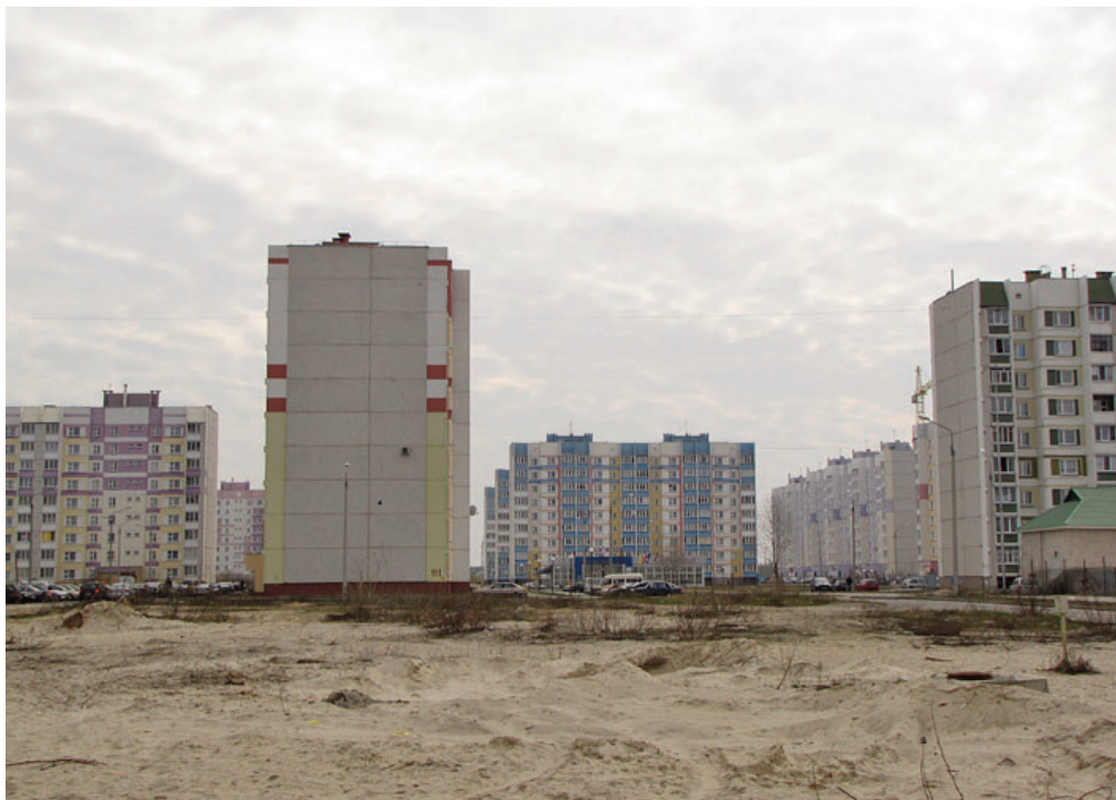
Рис. 2. Строительное освоение массивов намывных песков в микрорайоне «Мельников луг» в Гомеле (по [3])
