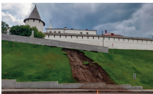
Рис. 3. Оползни на склонах Кремлевского холма по ул. Батурина, смоделированные в программе Google Earth и Surfer
