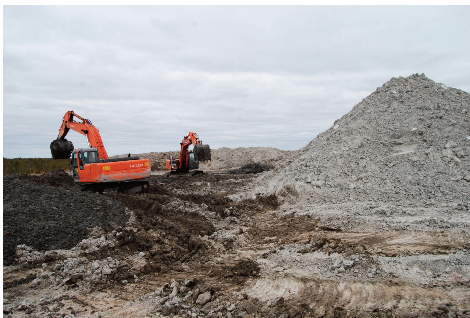
Рис. 4. Перемешивание загрязненных песчаных грунтов с цементным раствором в процессе рекультивации на одном из месторождений Западной Сибири (фото Григорьевой И.Ю.)
